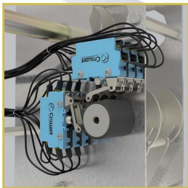
Contact auxiliaire (PBX) sur mécanisme de contrôle commande associé à une Ring Main Unit
